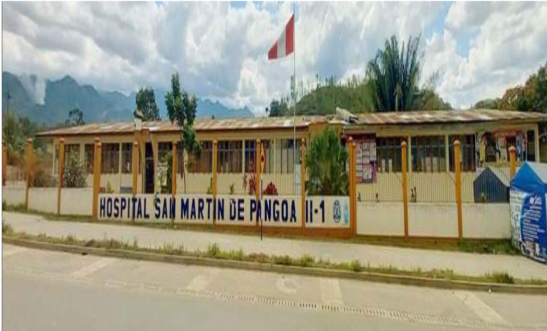
VISTA PANORAMICA DEL HOSPITAL SAN MARTIN DE PANGOA II-1
